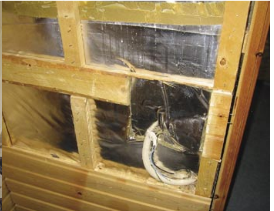
RAKENUSVAIHEEN LAIMINLYÖNNIT JOUDUTAAN MYÖHEMMIN KORJAAMAAN. TÄMÄN LÖYLYHUONEEN ALKUPERÄINEN ALUMIINIPAPERI ON VÄÄRIN ASENNETTU. SAUNA JA KYLPYTILOJEN KORJAUSTÖISSÄ KANNATTAÄ KÄYTTÄÄ LUOTETTAVAN AMMATILAISEN APUA.
