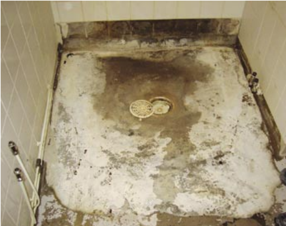
LATTIAN PINNAN POISTON JÄLKEEN SAATTAÄ NÄKYMÄ JOSKUS YLLÄTTÄÄ. TÄMÄN KYLPYHUONEEN LATTIASSA ON SELKEÄT VESIVAURIOT.
