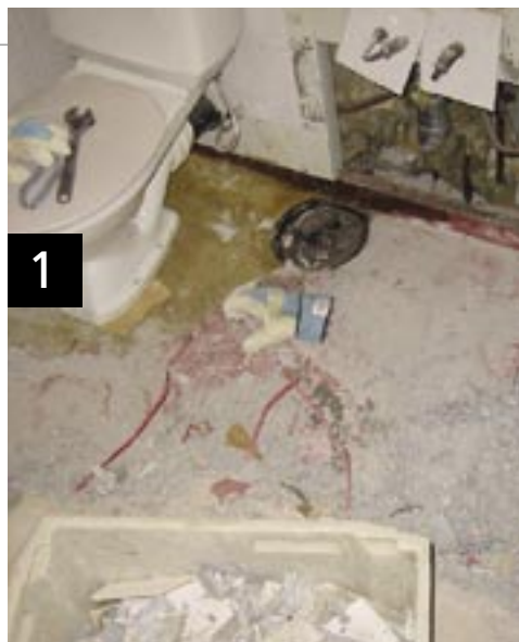
KUVA 1. PURKUVAIHEEN YLLÄTYS. TÄMÄN KYLPYHUONEEN LAATOITUS OLI TEHTY VANHAN MUOVIMATON PÄÄLLE JA VESITIIVISTYKSET OLIVAT JÄÄNEET TEKEMÄTTÄ.
